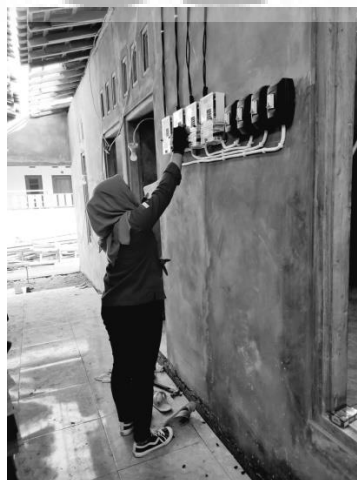
Gambar 1.7 Pengecekan fisik kwh meter prepaid
